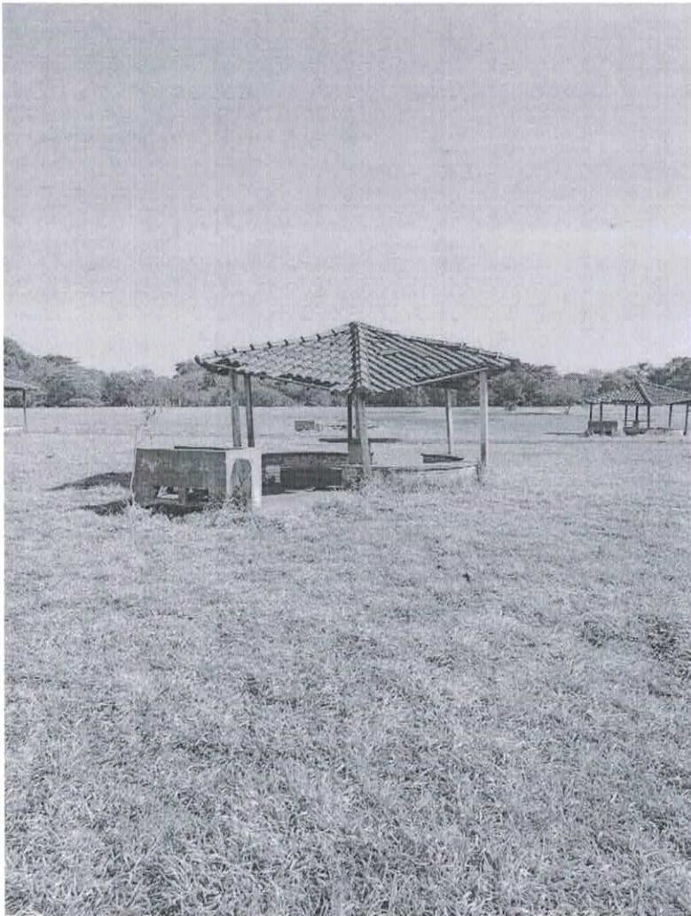
*Figura 2: Na Figura 02 consta a situação dos telhados dos quiosques que estão correndo risco de desabamento, o madeiramento das estruturas estão corroídos pela ação do tempo, em toda a sua maioria alguns deles já desabaram.*
