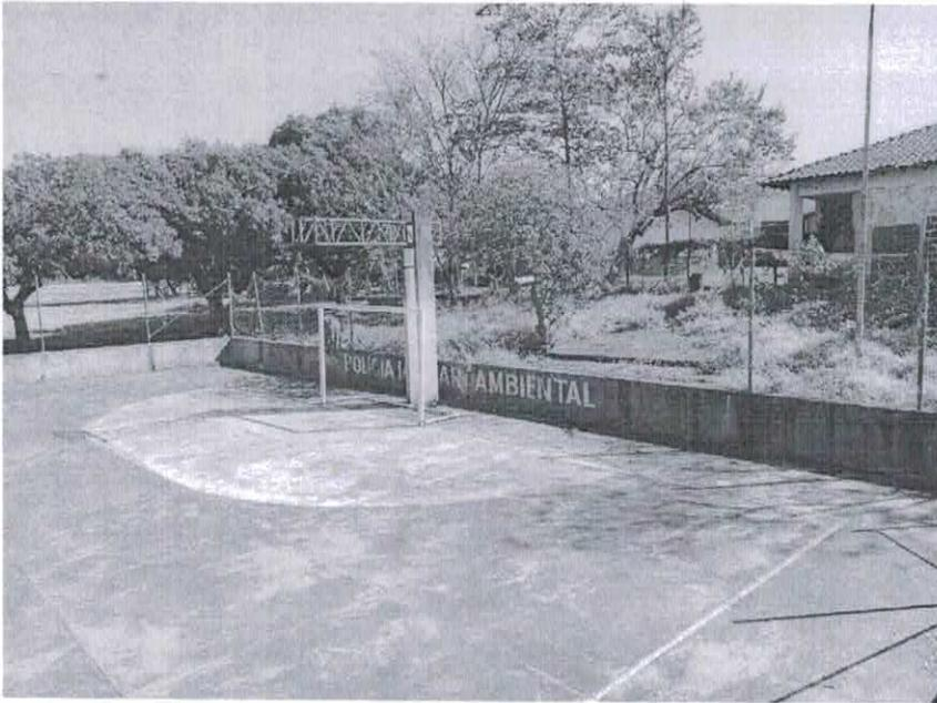
*Figura 1: Como consta na figura 01, as quadras poliesportivas estão sem tabela para pratica de esportes, sem sinalização de quadra, pintura completamente desgastada, alambrados destruídos, arbustos crescendo em meio as arquibancadas das quadras.*
