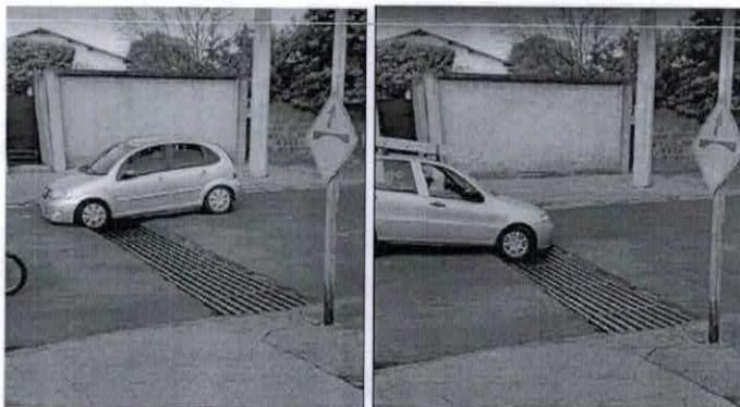
Dessa forma, solicita-se que a grelha de captação da água seja consertada e que, havendo necessidade, seja determinado sua reinstalação reforçada com uma elevação de altura para acabar com o abalroamento dos veículos.
